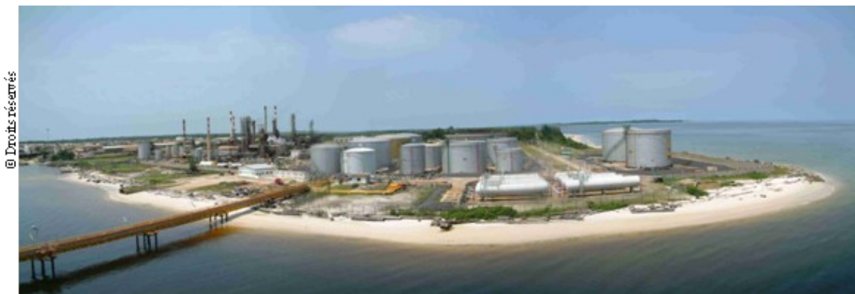
Raffinerie de Port Gentil
