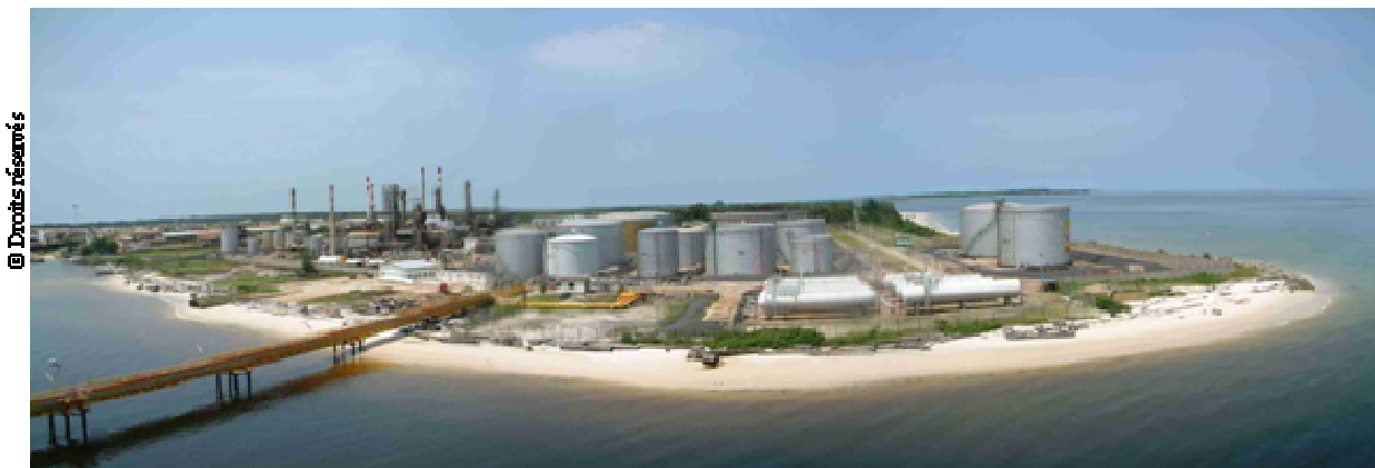
Raffinerie de Port Gentil
